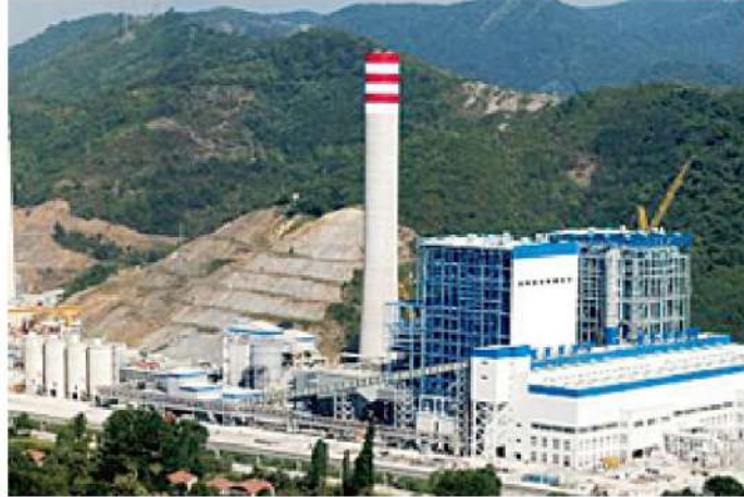
Zonguldak Eren Thermal Power Plant
